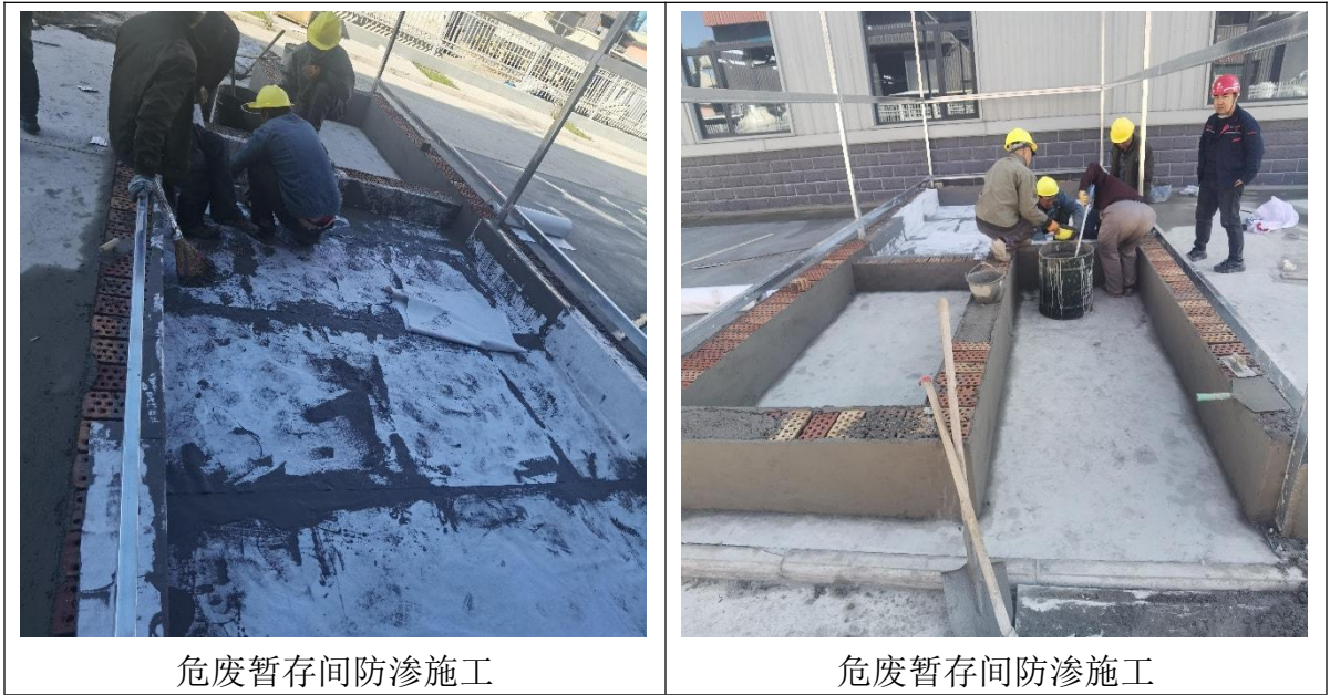
图 4-7 防渗施工照片
