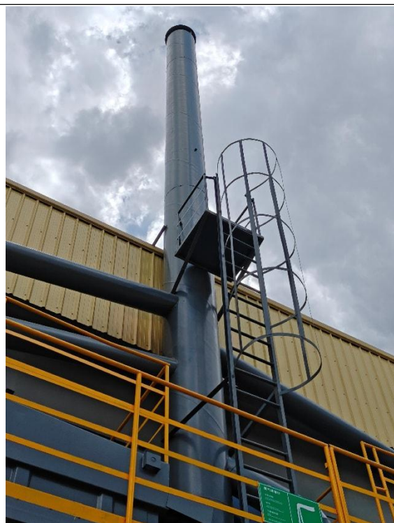
打磨废气排气筒（依托）
